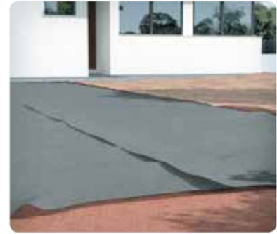
2 Colocar el geotextil PAVIGARDEN ANTIHIERBAS.
