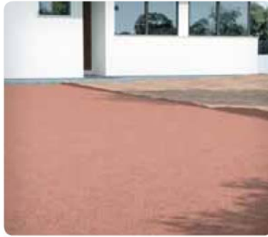
1 Limpiar, alisar y compactar el terreno.
